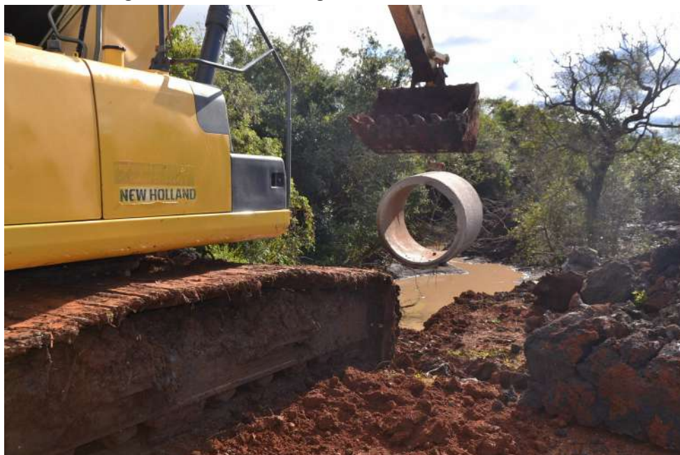
Figura 63 – Obras de Drenagem na rua João Lunardi do Amaral
