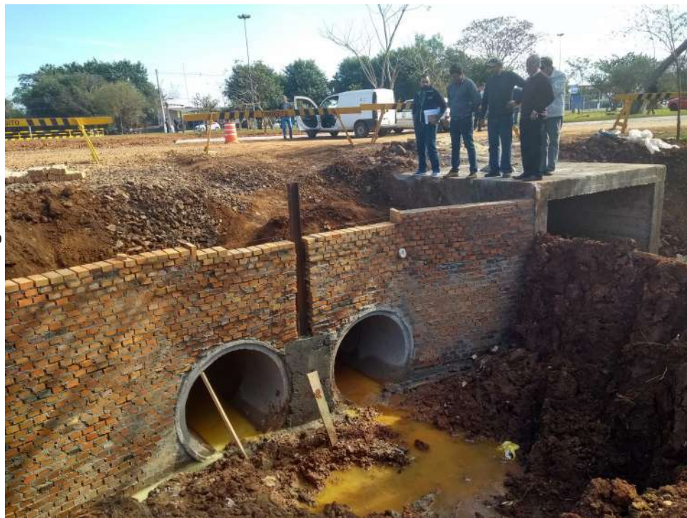
Figura 62– Obras de drenagem na Praça Tricentenário
