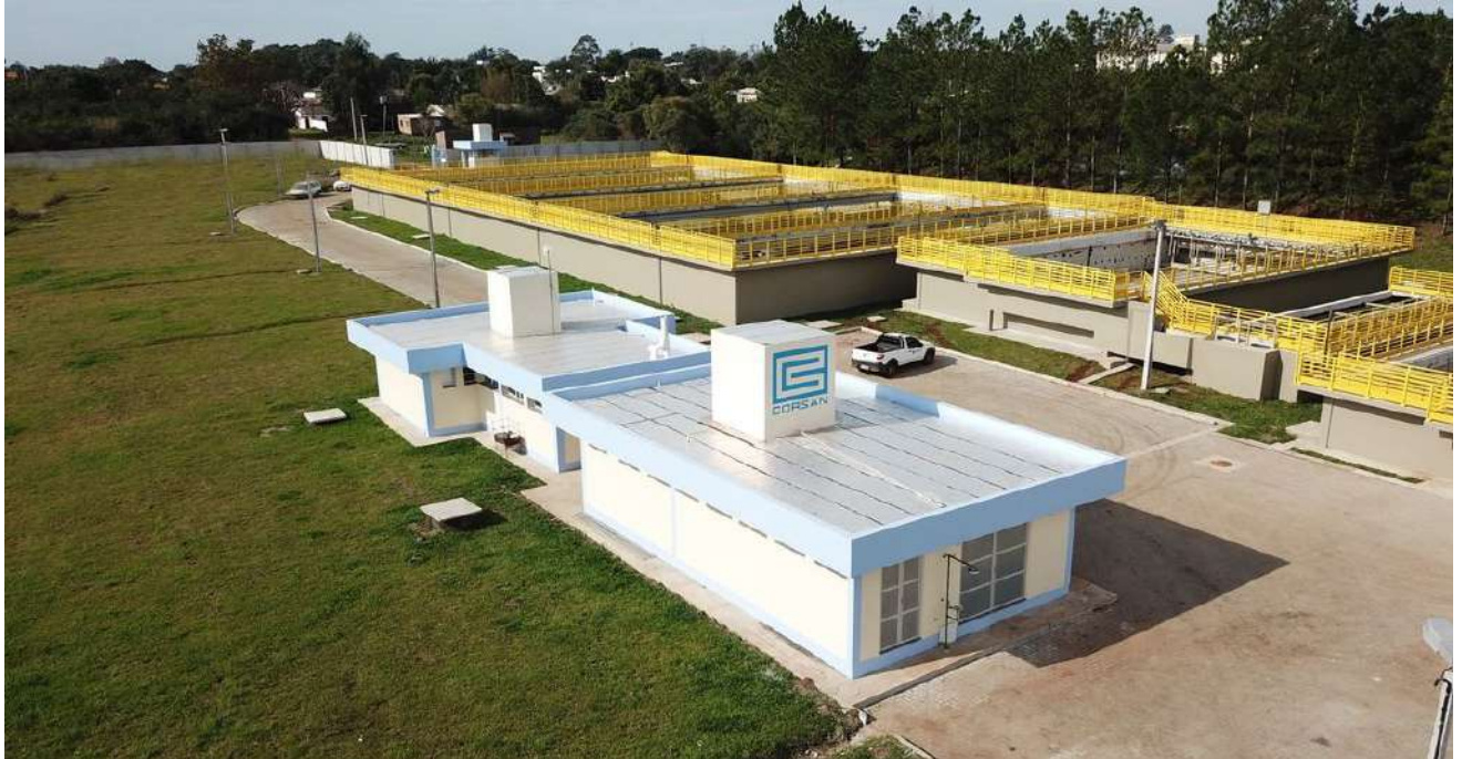
Figura 35 – Estrutura da ETA São Borja
