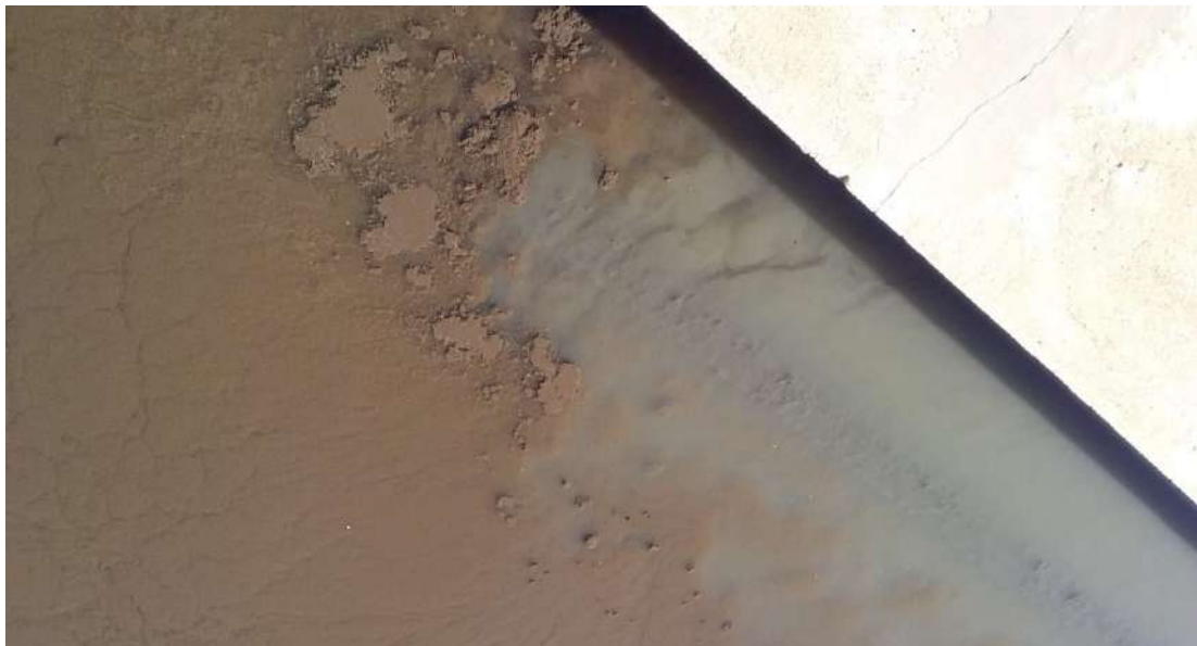
Figura 43– Entrada do esgoto no reator e processo de formação de lodo ativado
