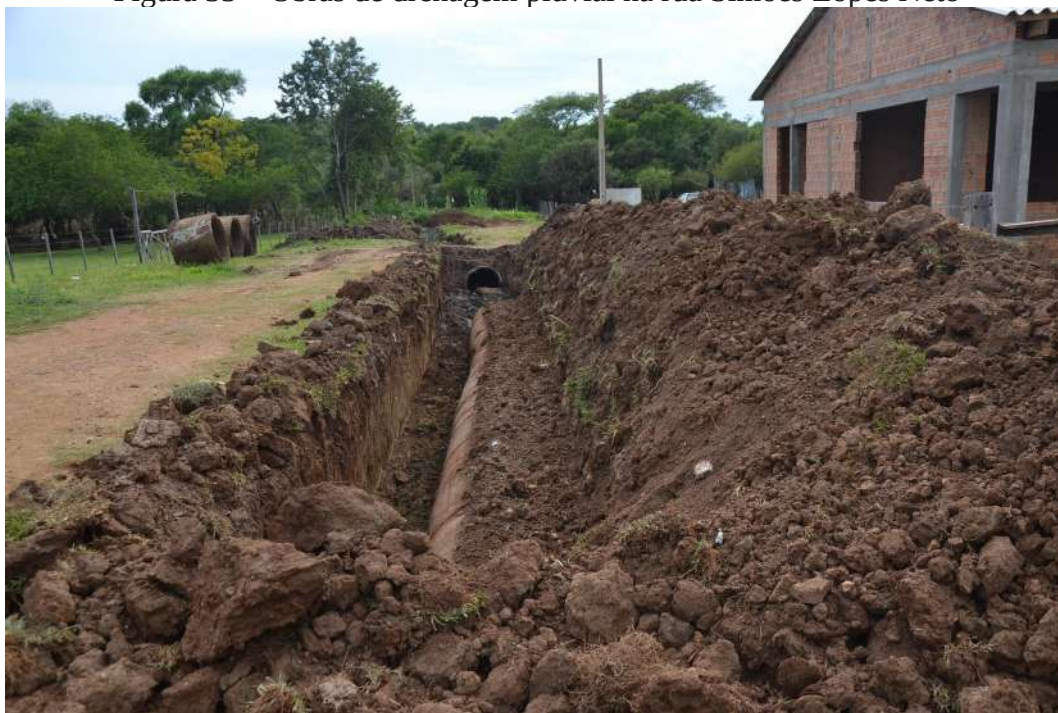
Figura 33 – Obras de drenagem pluvial na rua Simões Lopes Neto
