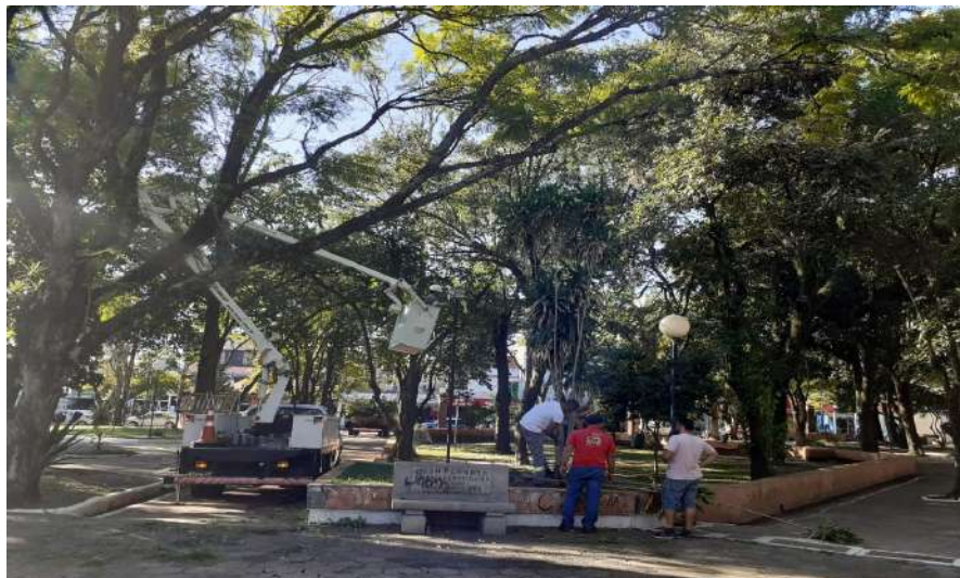
Figura 15- Equipe da SMIESUST executando manutenção em praça pública
