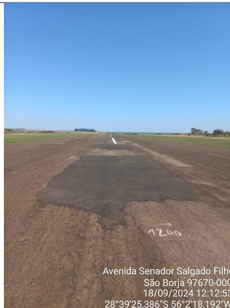
Figura 5 - Reparos realizados sem funcionalidade.
