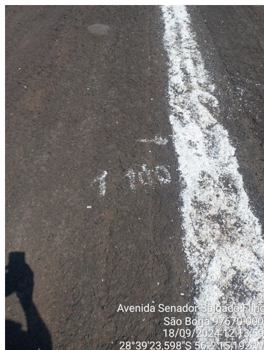
Figura 9 - Presença de trincas e limpeza com retirada dos agregados soltos
