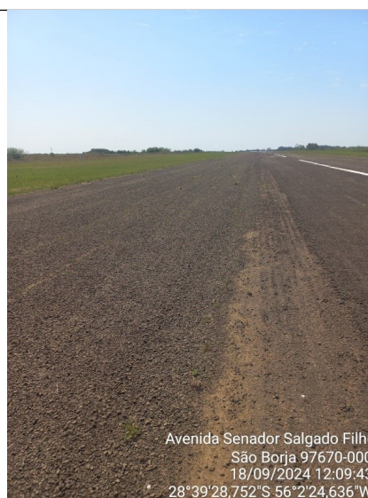
Figura 7 - Perda do ligante, desagregação
