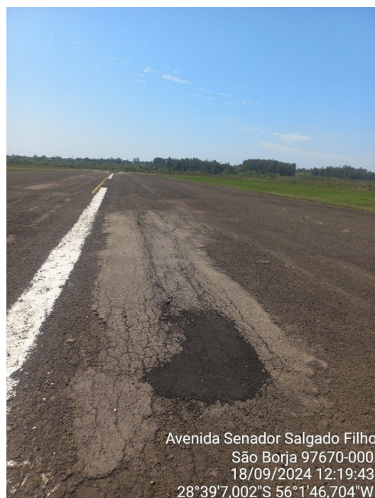
Figura 8 - Remendos realizados, com presença de trincas.
